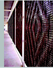
foto 1: realizzazione dei pannelli per il centro di cardiologia in Sudan (progetto di Tamassosai) foto 2: i pannelli posizionati lungo il corridoio dell'ospedale.
