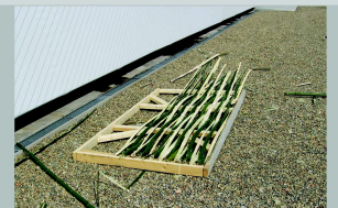
realizzazione della quinchá durante il workshop "costruire con la gente" Milano giugno 2008
