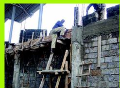
Le impalcature in legno utilizzate, sono molto precarie e poco sicure. Direttamente in loco e con mezzi manuali viene realizzata la malta cementizia.
